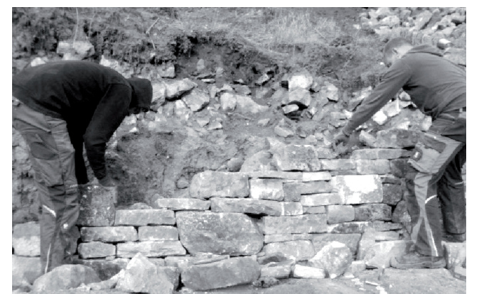
Die Sanierung konnte vor Weihnachten erfolgen
